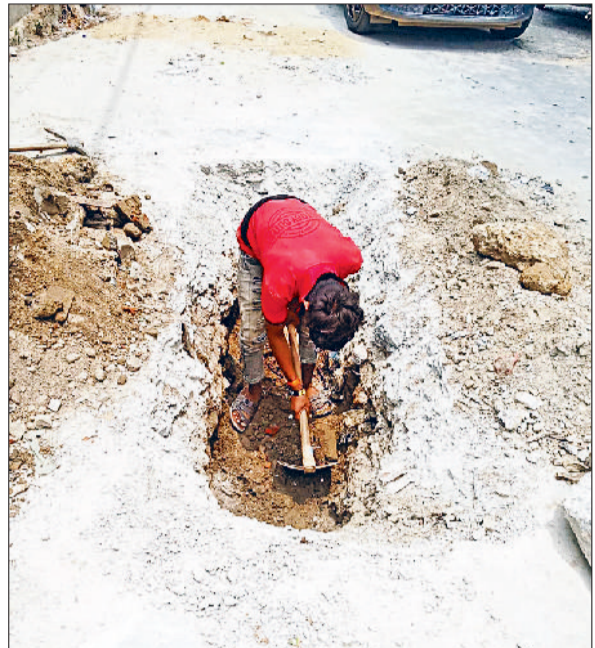
रेवाड़ी। धारुहेड़ा में भूमिगत बिजली लाइन के लिए सड़क तोड़ता कर्मचारी व धारुहेड़ा में भूमिगत बिजली लाइन के लिए तोड़ी गई नई सड़क व खासापुरा मोहल्ले में बिना परमिशन के डाली गई सीवर लाइन।
